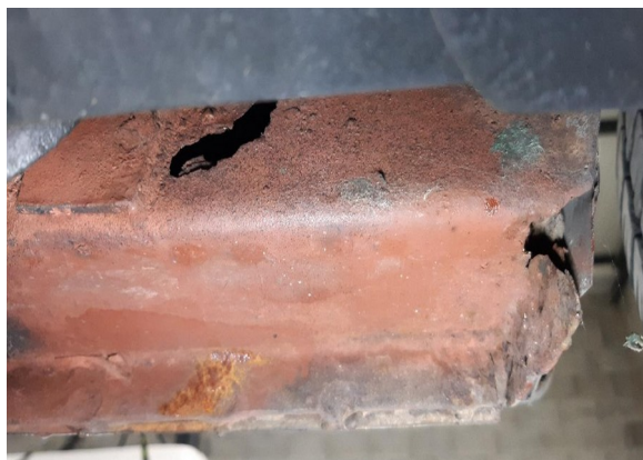
Point de corrosion perforant sur le bas de caisse droit
