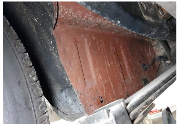
Point de corrosion perforante sur la bas de caisse gauche
